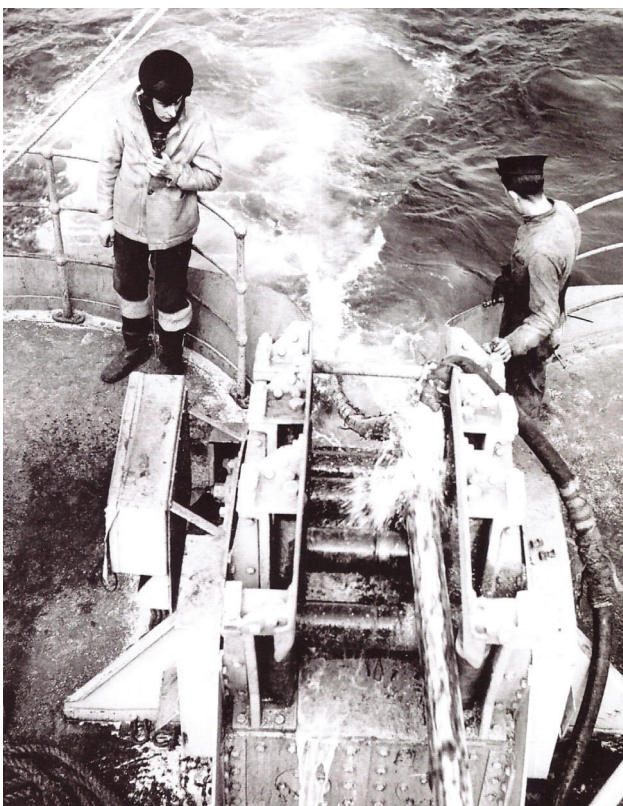
Figura 4 – Instalação do oleoduto submarino (Operação Pluto) pelos marinheiros do Reino Unido Fonte: Vázques, 2009, p. 52
