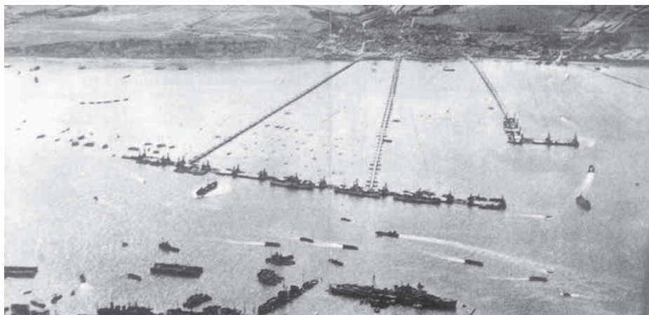
Figura 2 – Vista aérea do porto artificial (Mulberry B) em Arromanches
