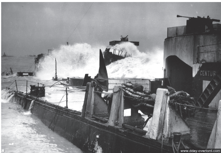
Figura 3 – Porto artificial (Mulberry A), na Praia de Omaha, danificado após a forte tempestade, em 19 junho de 1944
