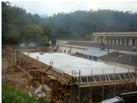
Obras de construção do novo refeitório
