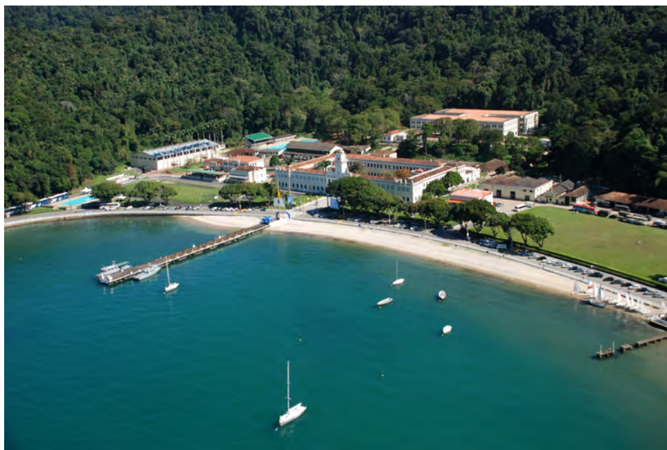
Vista aérea atual do Colégio Naval
