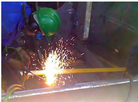
Fig. 3 – Corte com maçarico no interior do espaço confinado
