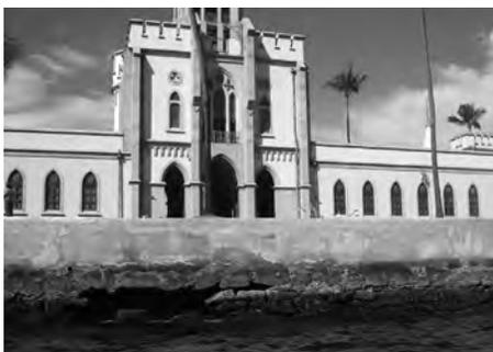
Figura 1 – Falha no paramento do cais norte
