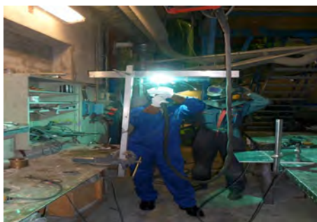
Militar da BNVC realizando soldagem sobre cabeça nas instalações da Dockstavarvet
