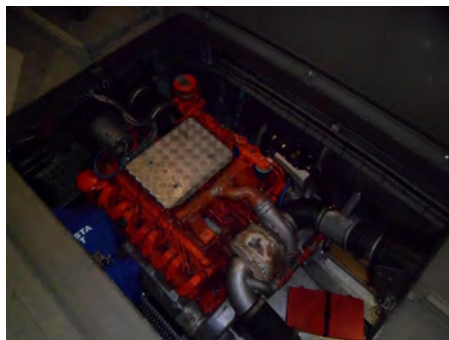
Praça de máquinas
