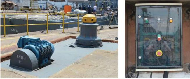
Figura 23 – Cabrestantes e instalações elétricas modernizadas
