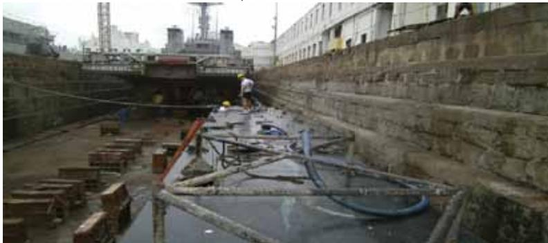
Figura 5 – Flutuante docado no dique da BNRJ, após a conclusão da faina de reflutuação.
