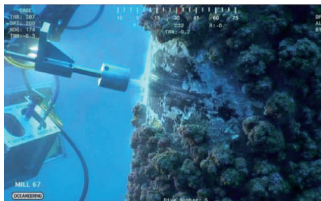
Limpeza submersa por ROV pelo método de jato de água de cavitação 6
