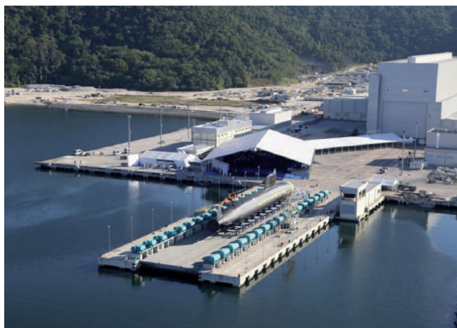
Vista aérea da BSIM – Nova sede da Força de Submarinos.
