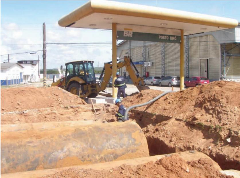
Figura 9 - Degaseificação de tanque no CeIMNa (Fonte: Relatório GeoTech Engenharia e Meio Ambiente, 2020).
