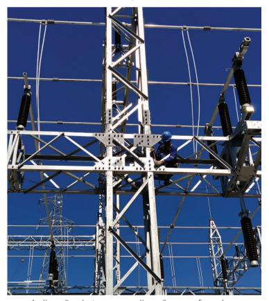
Aplicação de torque na ligação parafusada.
