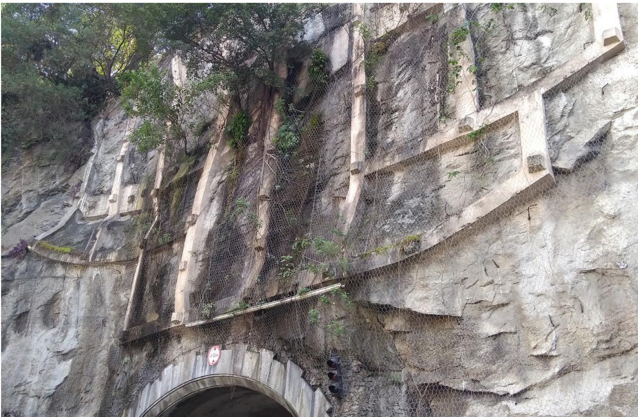
Figura 7 – Sistema de contenção com tela metálica e grelha atirantada, no Arsenal de Marinha do Rio de Janeiro (AMRJ) Fonte: DOCM.
