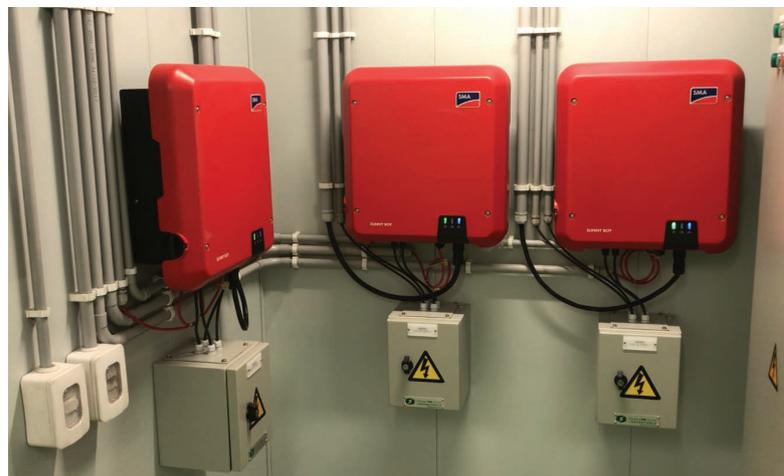
Figura 4 - Inversores solares da nova EACF. Fonte: SECIRM, 2020.
