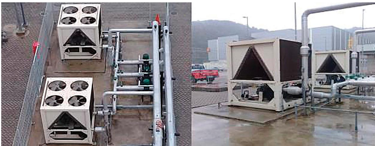
Figura 1 – Central de água gelada de um sistema central de HVAC
