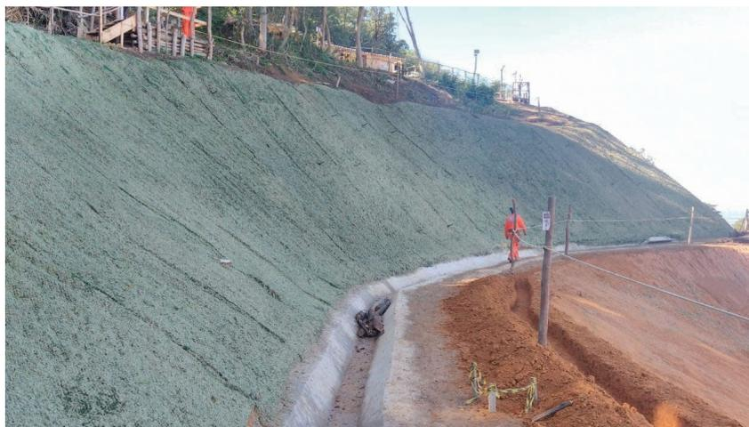
Figura 4 – Retaludamento executado em 2017, em encosta do Depósito de Combustíveis da Marinha no Rio de Janeiro (DepCMRJ). Fonte: DOCM.
