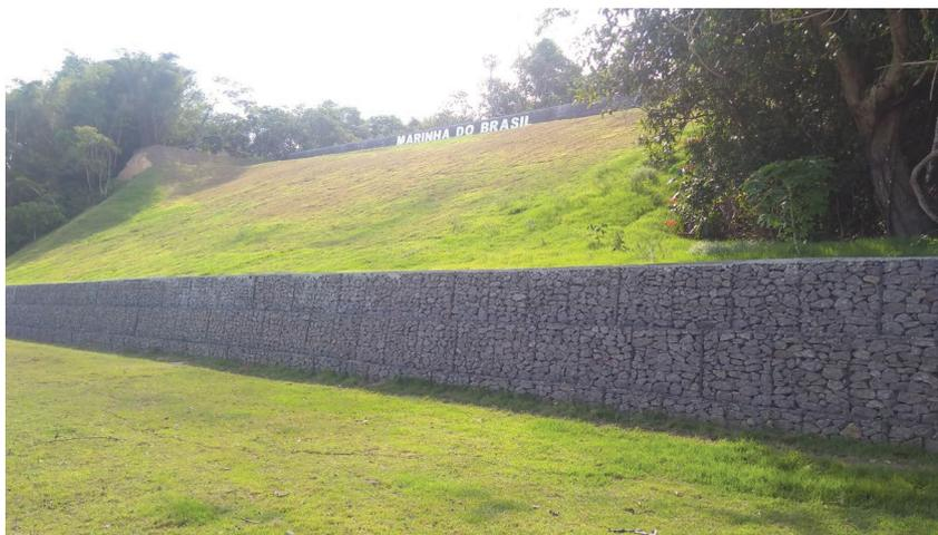
Figura 5 – Sistema de retaludamento com muro de contenção do tipo gabião, executado em 2018 na ENRN, Manaus-AM. Fonte: DOCM.
