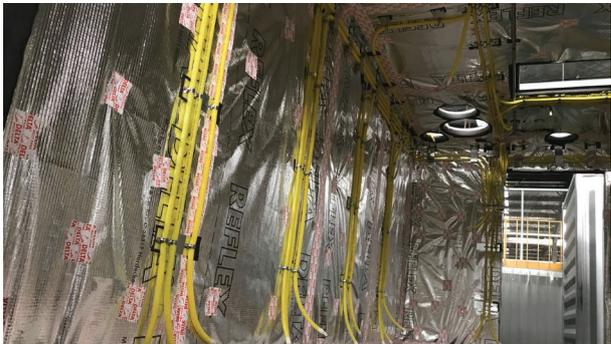
Montagem das instalações prediais nos módulos contêineres.
