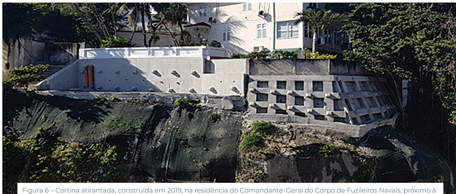
Figura 6 – Cortina atirantada, construída em 2019, na residência do Comandante-Geral do Corpo de Fuzileiros Navais, próximo à entrada do Arsenal de Marinha do Rio de Janeiro. Fonte: AMRJ.
