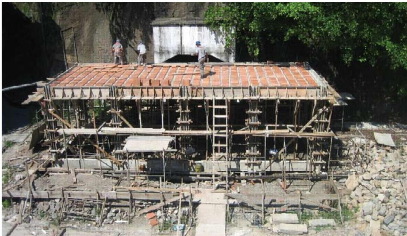
Figura 5 - Construção do prédio para a nova subestação de energia elétrica.
