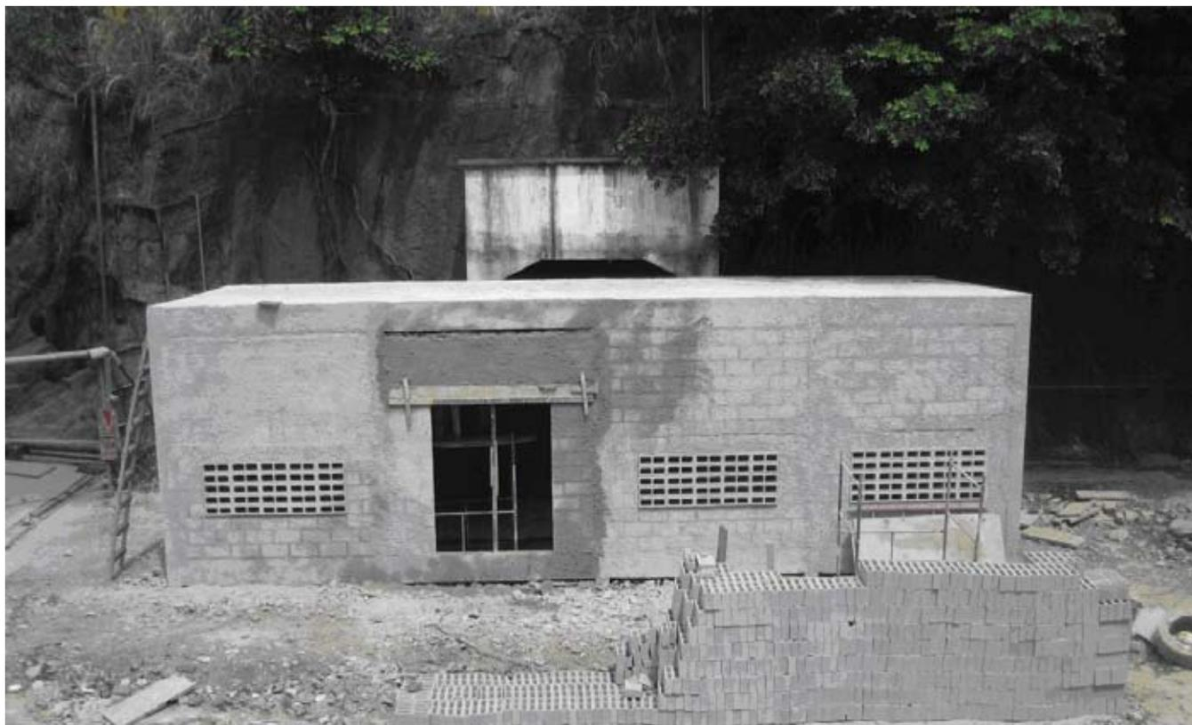
Figura 6 - Finalização da alvenaria do prédio da subestação.
