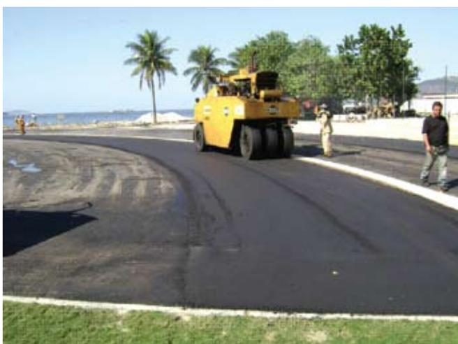
Figura 12 - Construção de base, em asfalto, para uma nova pista de atletismo.
