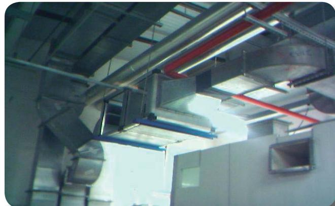
Figura 1 - Dutos de um sistema de ar condicionado central
