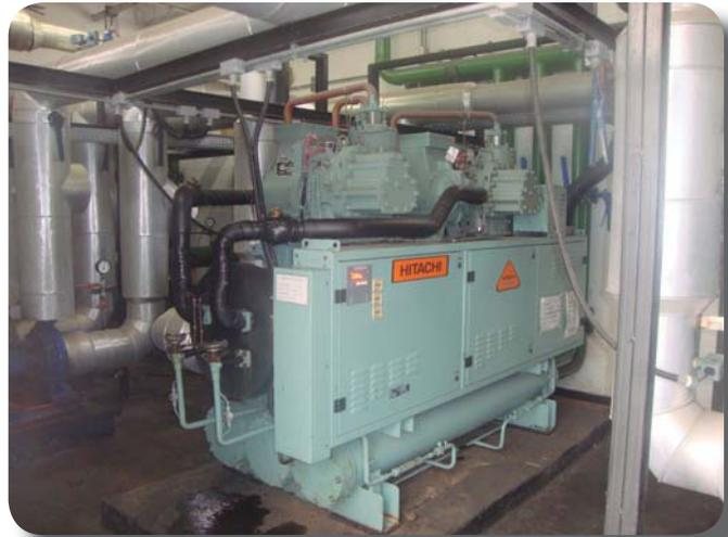
Figura 2 - Unidade Refrigeradora de Líquido - Chiller - Sistema de Ar condicionado de Expansão Indireta por Água Gelada
