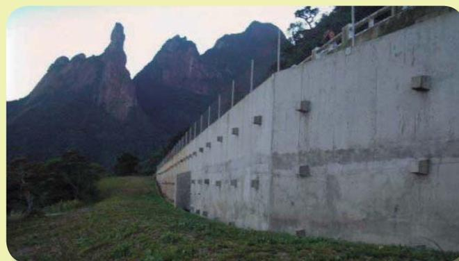
**Figura 1b** - Cortina atirantada utilizada em obra de contenção de encosta em trecho da rodovia BR-116-RJ
