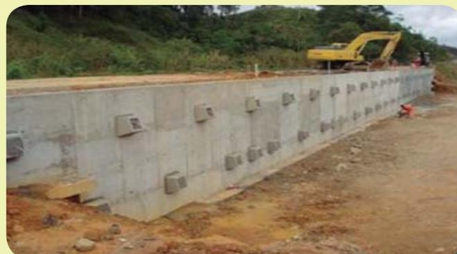
**Figura 1a** - Cortina atirantada executada na Rodovia BR-116 no trecho entre as cidades de Miracatu e Barra do Turvo (SP) - Fonte: [www.sobrenco.com.br](http://www.sobrenco.com.br)
