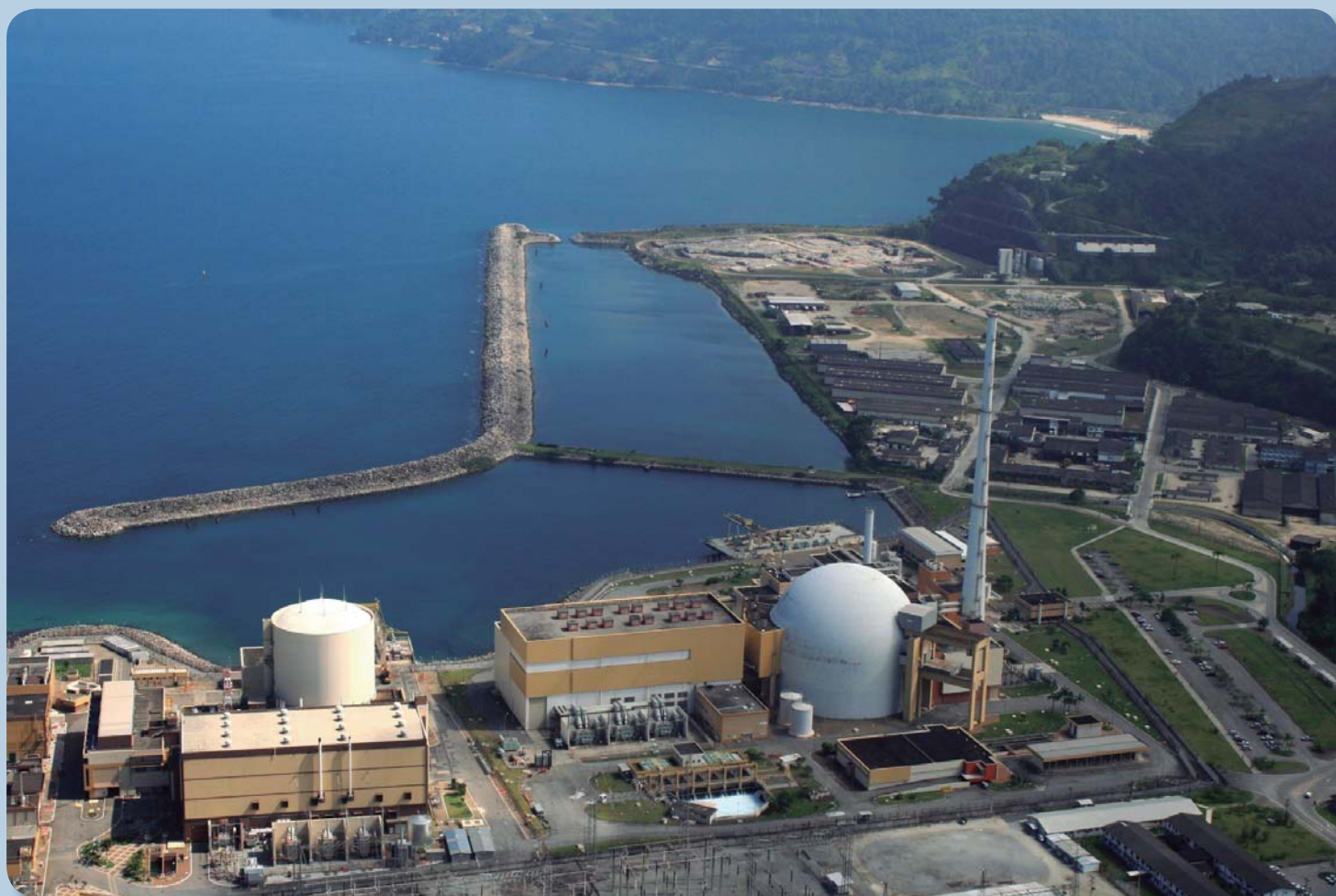
Figura 7 - Vista da Central Nuclear Almirante Álvaro Alberto (CNAAA), em Angra dos Reis-RJ. Fonte: Galeria de Imagens do sítio http://www.eletronuclear.gov.br , visitado em 10/08/2011.
