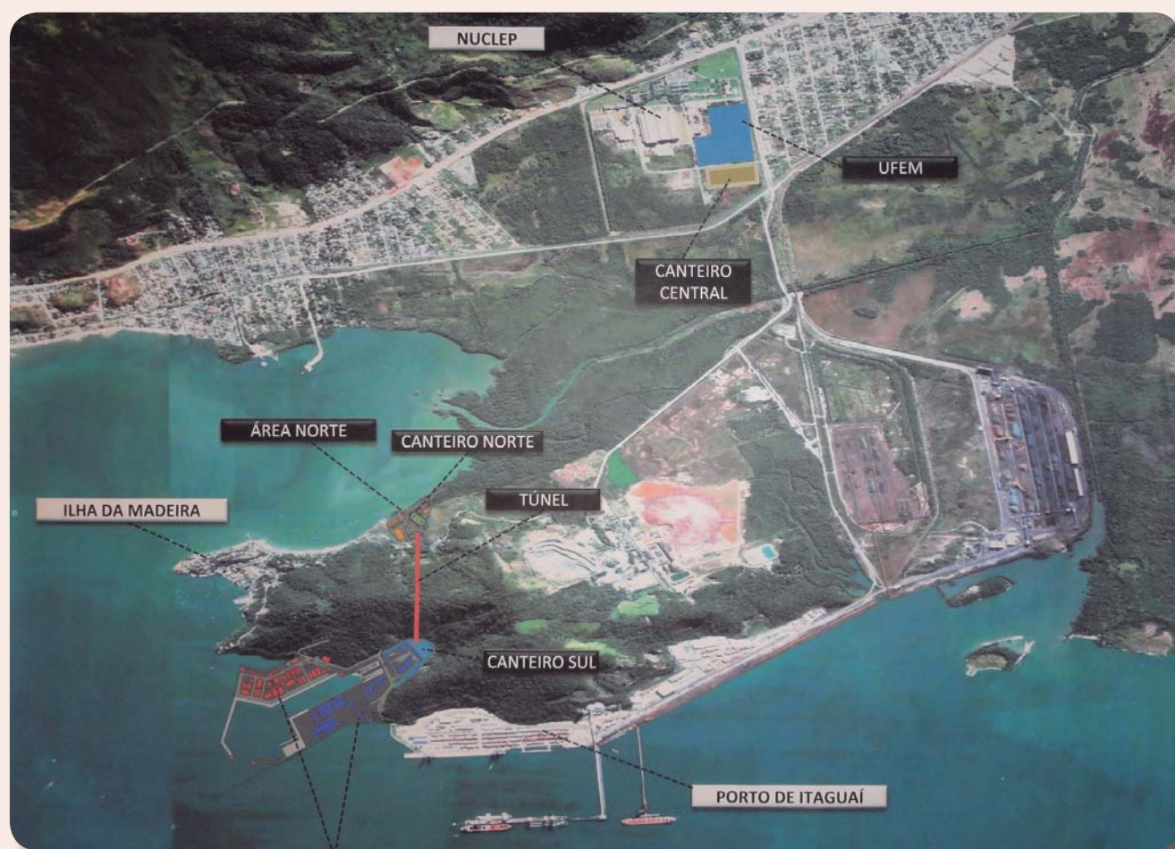
Figura 1 - Localização das obras civis do PROSUB.
