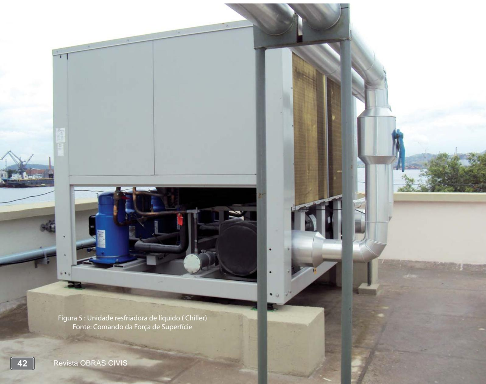
Figura 5 : Unidade resfriadora de líquido ( Chiller)
