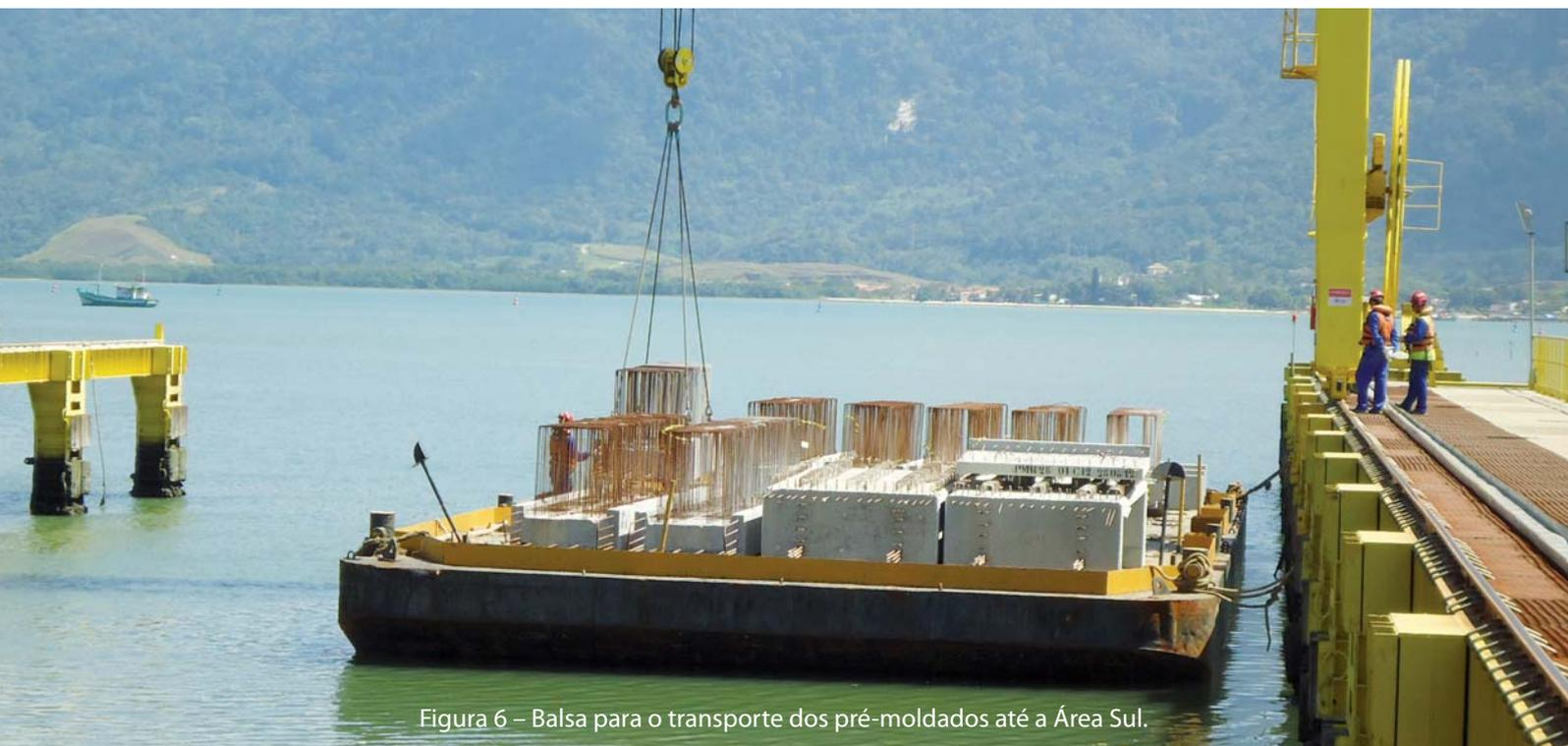
Figura 6 – Balsa para o transporte dos pré-moldados até a Área Sul.
