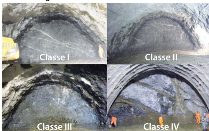
Figura 2 – Classificação do maciço (BARTON *et al*, 1974), durante a execução das escavações do túnel do EBN.
