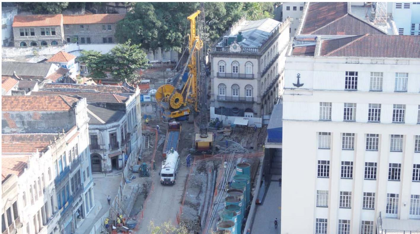
Figura 9 – Vista das obras de construção do túnel (mergulhão) do Porto Maravilha, no Rio de Janeiro - RJ, com escavações próximas às edificações da MB.
