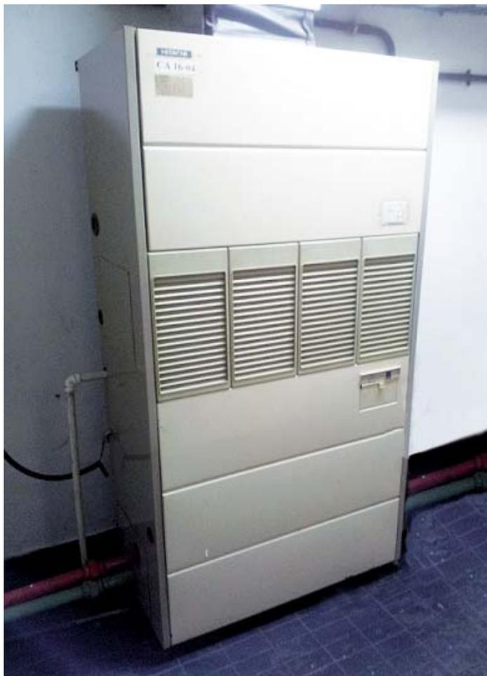
Figura 2 : Condicionador de ar tipo self-contained
