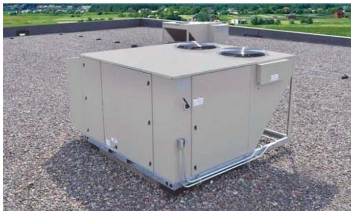
Figura 3 : Condicionador de ar tipo "roof-top"
