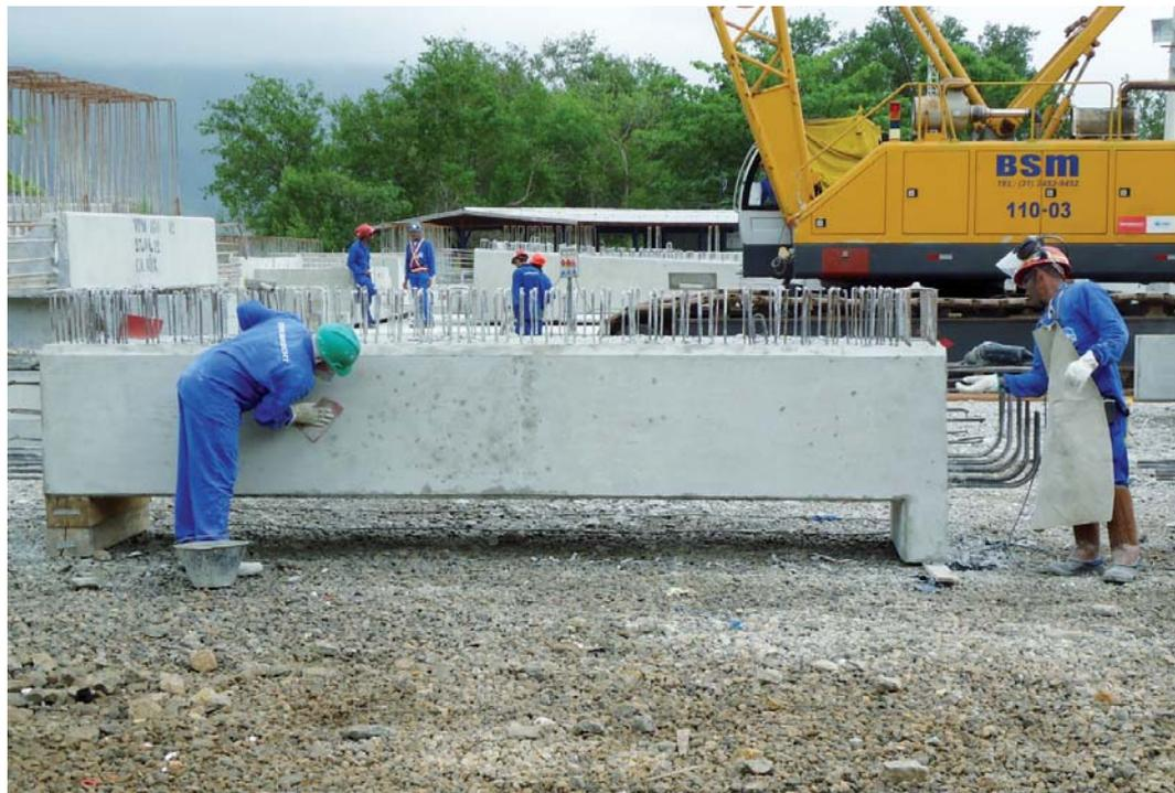
Figura 4 – Lixamento da peça após o estucamento.
