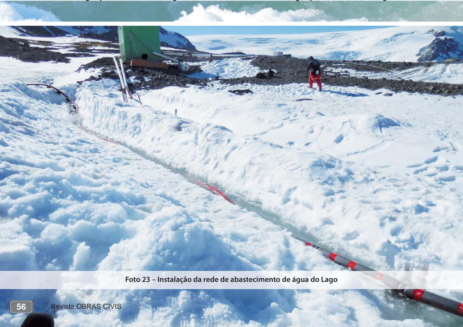
Foto 23 - Instalação da rede de abastecimento de água do Lago
