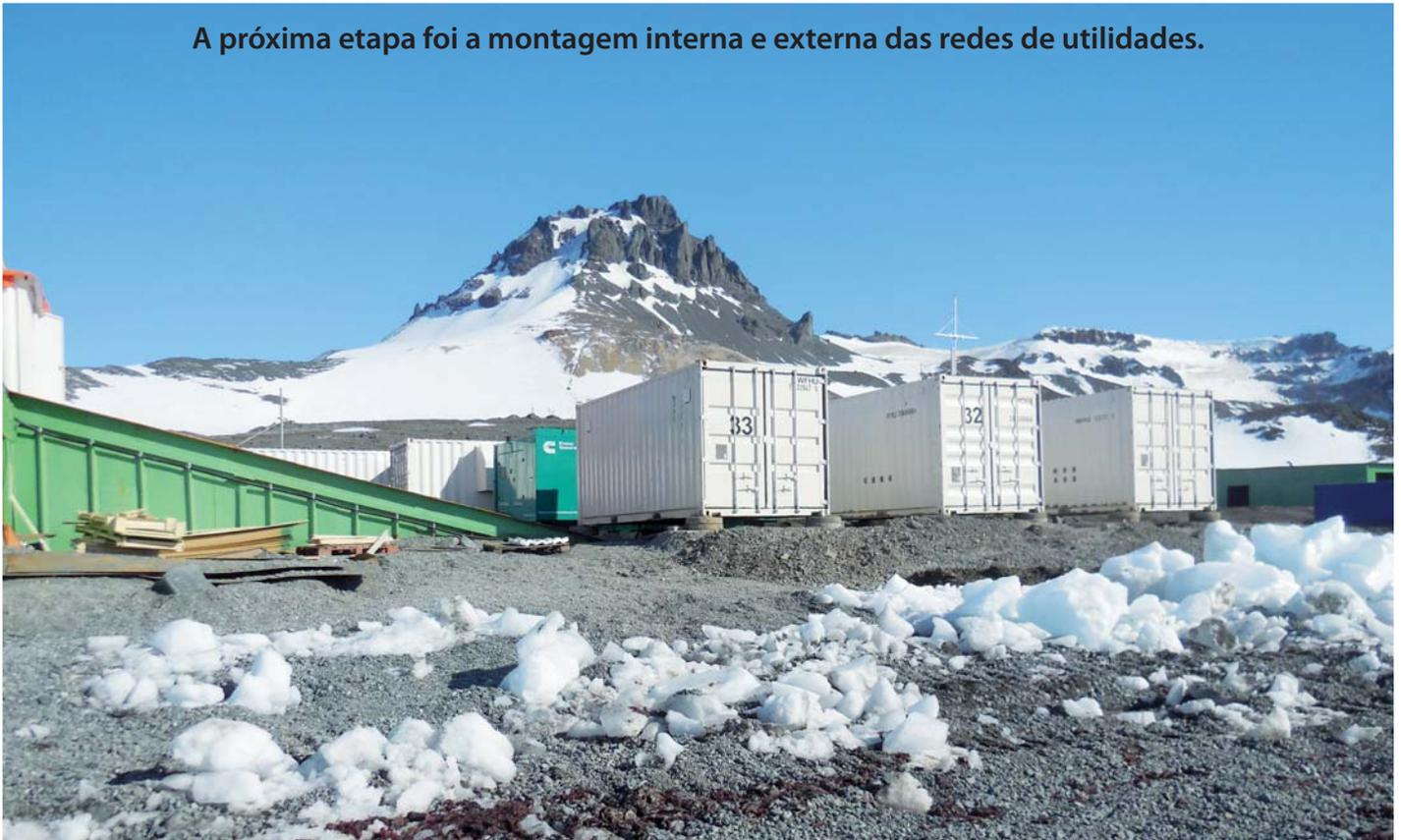
Foto 26 - Containers de distribuição e tratamento de água e esgoto
