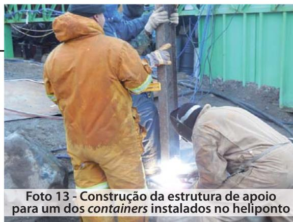
Foto 13 - Construção da estrutura de apoio para um dos *containers* instalados no heliponto
