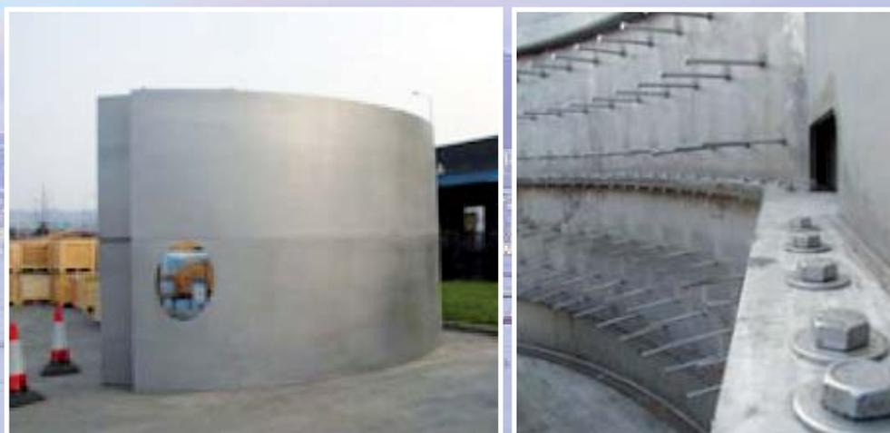
Figura 2 - Stonecutters Bridge - Peça em Aço Inoxidável - Vista Externa e Vista Interna
