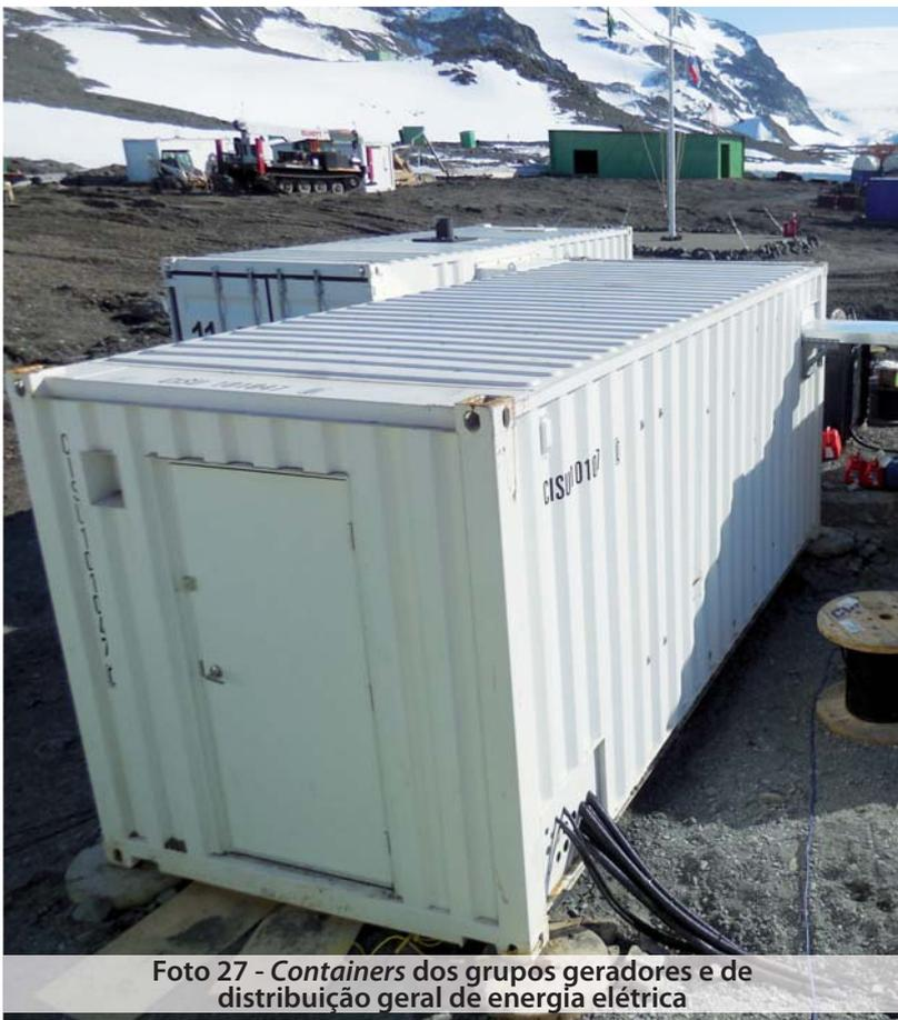
Foto 27 - Containers dos grupos geradores e de distribuição geral de energia elétrica
