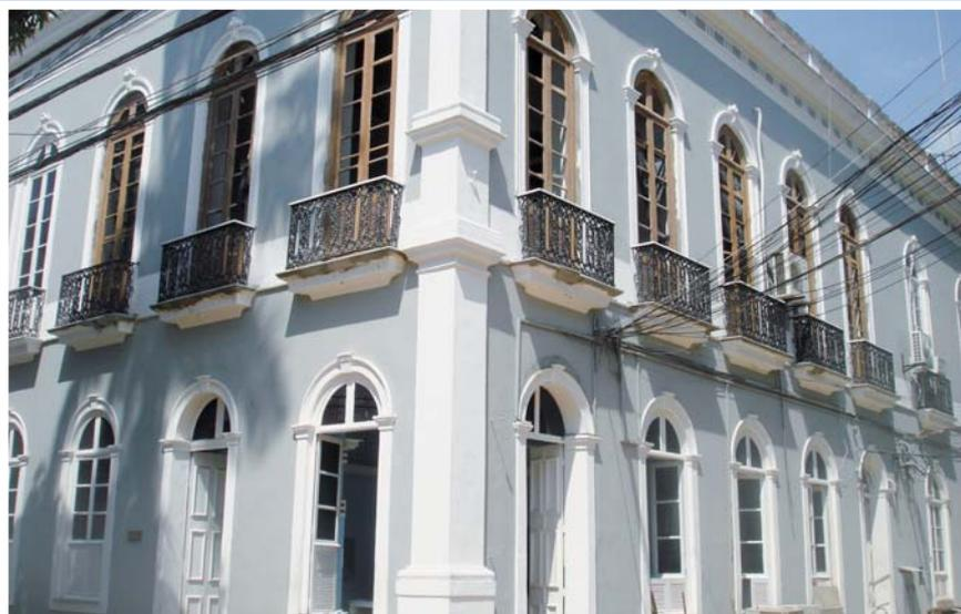
Reforma geral do prédio histórico do Comando do 4º Distrito Naval, com conservação de suas características originais, sendo realizada a substituição total das esquadrias, das instalações elétricas e lógica, retirada de infiltrações com aplicação de manta sob reboco, reparo do piso de madeira com substituição de peças danificadas. Realizada ainda a substituição, com segregação, das redes de drenagem e esgoto sanitário e pavimentação de ruas internas do Complexo.
