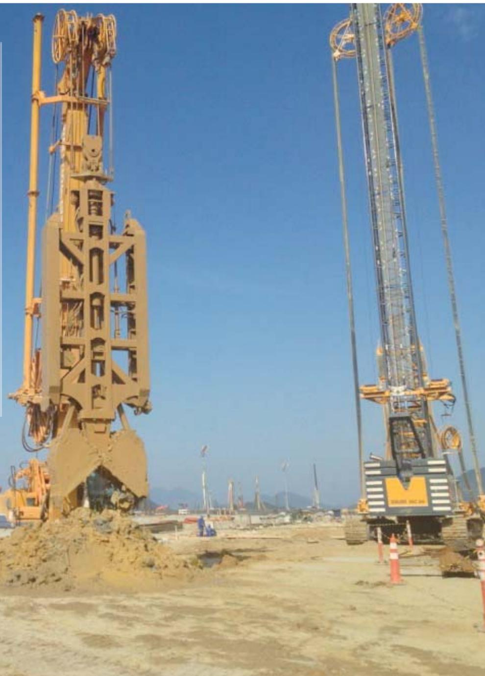
Figura 2 – Escavação com *Clam Shell*
