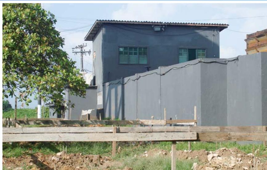
Construção de um novo poço artesiano, novo aerador e um novo tanque de pré-filtros e filtro, além de reforma com adaptação das antigas instalações, para um novo sistema de tratamento, mais adequado para a água captada naquele Complexo Naval, com capacidade para produzir até 90 m<sup>3</sup>/h de água tratada.
