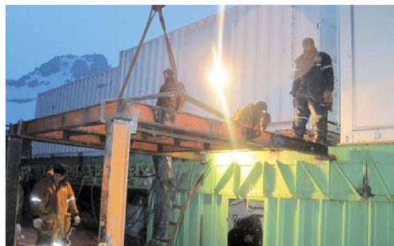
Foto 14 - Construção de estrutura de apoio para um dos *containers* instalados no heliponto
