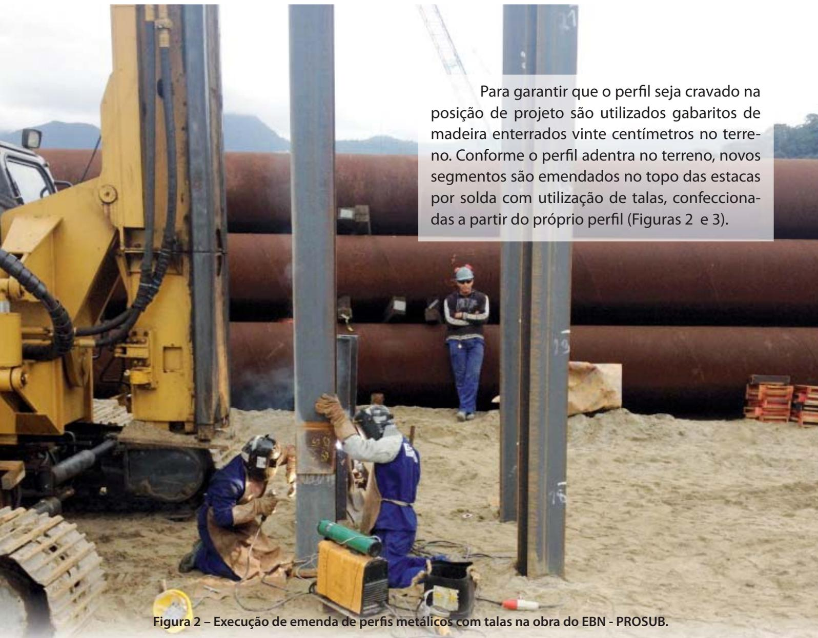
Figura 2 – Execução de emenda de perfis metálicos com talas na obra do EBN - PROSUB.
