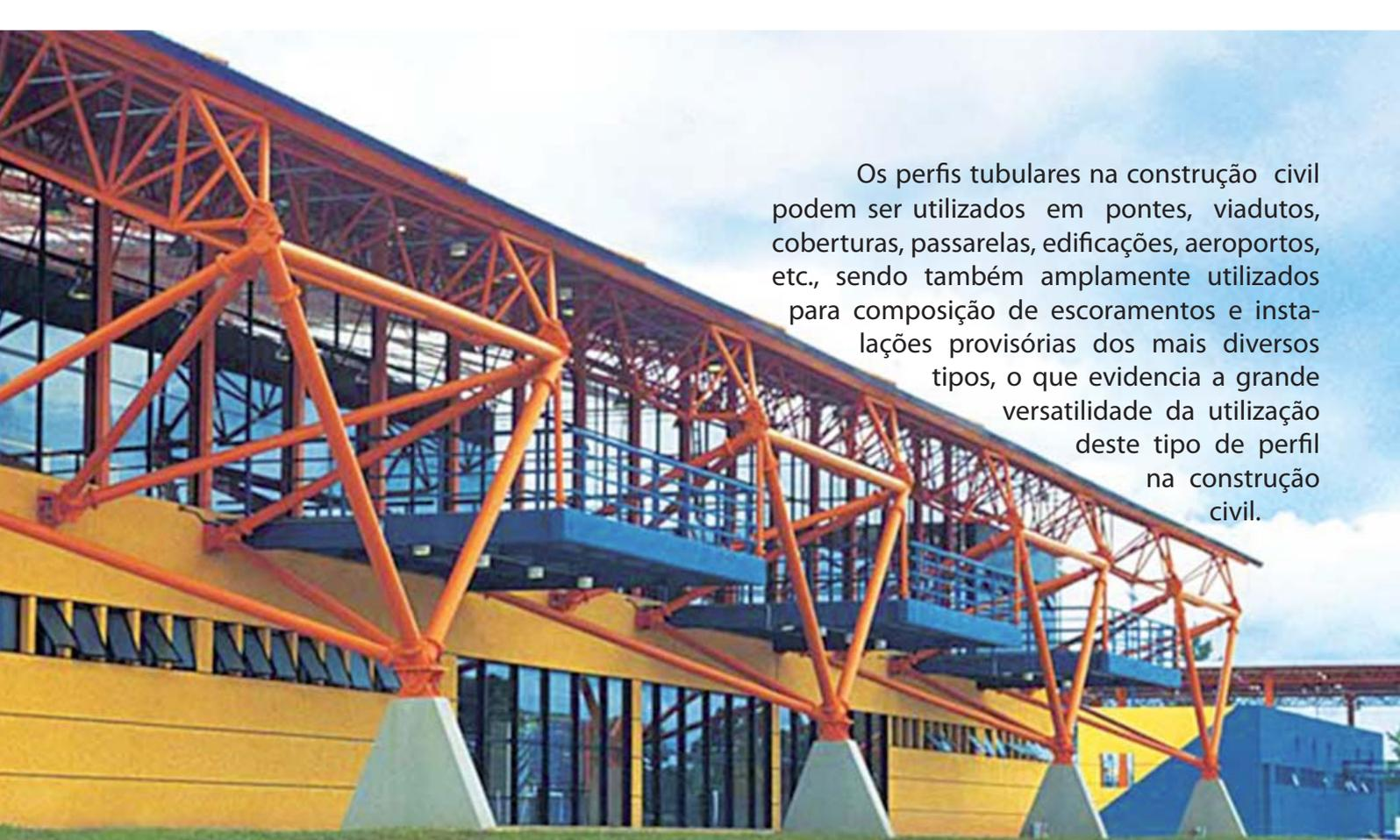
Os perfis tubulares na construção civil podem ser utilizados em pontes, viadutos, coberturas, passarelas, edificações, aeroportos, etc., sendo também amplamente utilizados para composição de escoramentos e instalações provisórias dos mais diversos tipos, o que evidencia a grande versatilidade da utilização deste tipo de perfil na construção civil.
