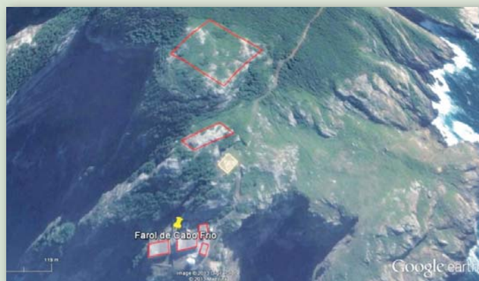
Figura 9 - Áreas para instalação de módulos fotovoltaicos no Farol de Cabo Frio. (Fonte: Google Earth).
