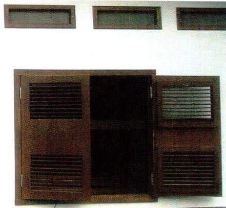
Figura 7 - Detalhe da ventilação superior e das janelas com venezianas móveis.
