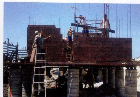
Figura 4 - Montagem do sistema viga-laje.
