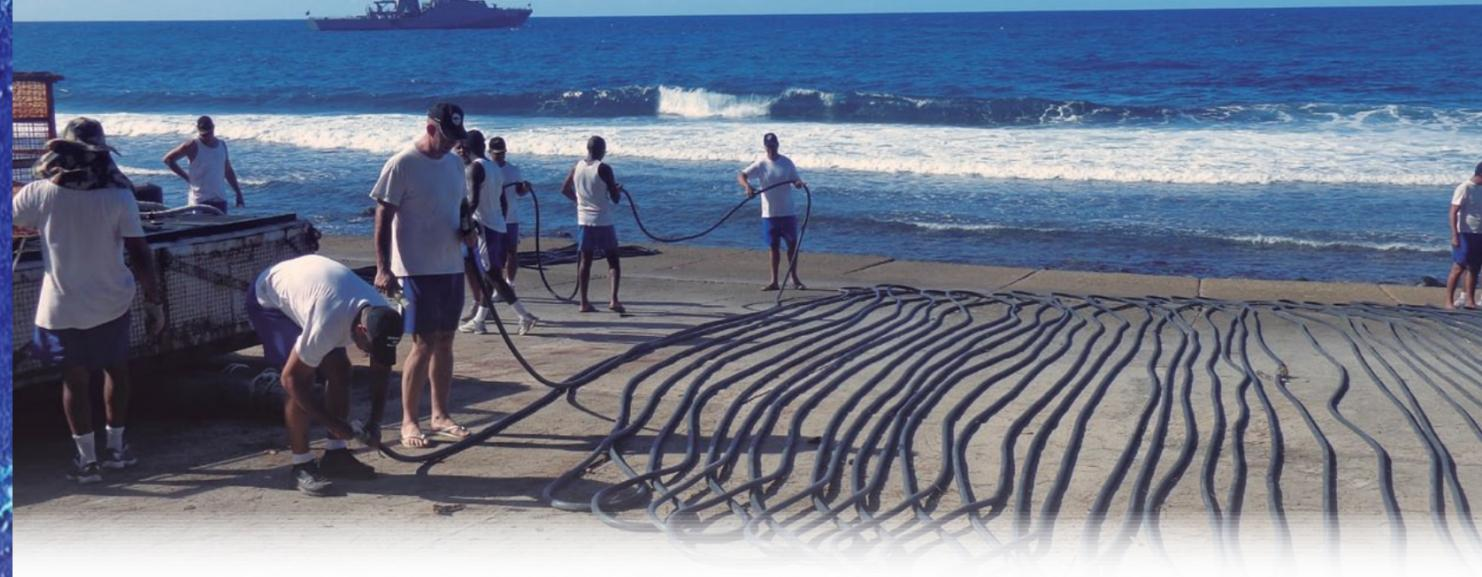
No dia 25 de março deste ano, foi testado, com êxito, o novo método de abastecimento de óleo combustível na Ilha da Trindade, usando mangotes conectados entre o Navio e o Posto Oceanográfico da Ilha da Trindade (POIT). Até então, o combustível era transportado em tambores com 200 litros de capacidade, por meio de aeronaves ou botes, condicionado às boas condições de mar e vento.
