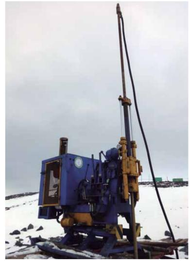
Realização de sondagem rotativa durante as prospecções geotécnicas, realizadas em 2014
