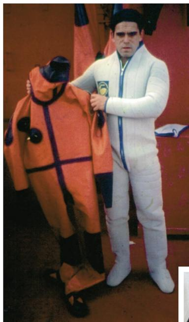
O traje especial da primeira viagem era composto por três peças: uma ceroula, um traje especial acolchoado fino, revestido por resina reflexiva e maleável, e tecido emborrachado impermeável, com capuz integrado, fechamento com zíper externo
