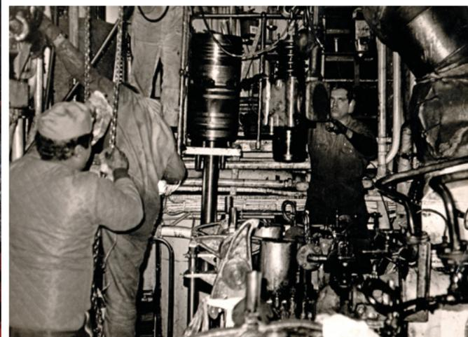
**Início do reparo do mancal do MCP com a retirada da válvula de descarga do cilindro**
