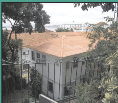
A BHMN realizou em 2011 a reforma do telhado do prédio da Divisão de Saúde, com a substituição do madeiramento da estrutura e das telhas coloniais por telhas onduladas que proporcionou maior resistência ao vento e maior
