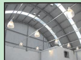
onde foram instalados exaustores eólicos e telhas onduladas opacas e transparentes, que buscou maior eficiência no uso dos recursos naturais. Em julho de 2012, foram finalizadas as obras de reforma das instalações elétricas, banheiros, copa e acabamentos dos compartimentos, possibilitando melhor acomodação aos motoristas e segurança para as viaturas.
