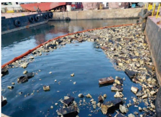
Figura 7 – Utilização de barreiras de contenção impedem que o material de disperse na coluna d'água, bem como que resíduos sólidos e eventualmente oleosos também se espalhem no mar, nas proximidades do Cais da Equipemar, Niterói-RJ. Fonte: AWS Service, 2023
