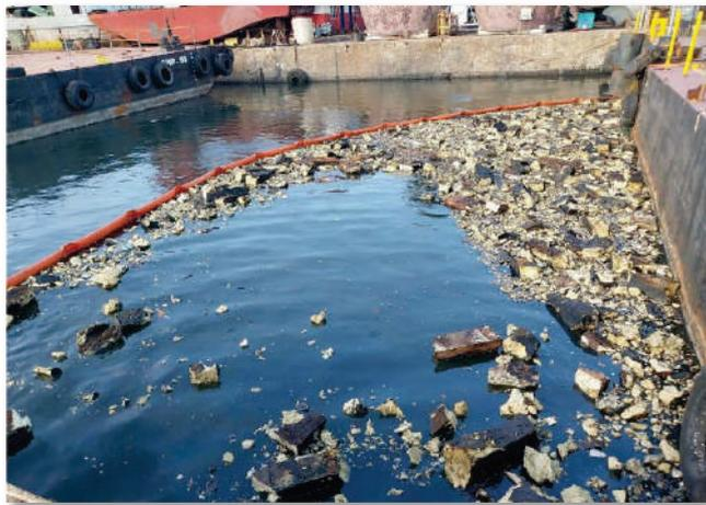
Figura 7 – Utilização de barreiras de contenção impedem que o material de disperse na coluna d'água, bem como que resíduos sólidos e eventualmente oleosos também se espalhem no mar, nas proximidades do Cais da Equipemar, Niterói-RJ. Fonte: AWS Service, 2023
